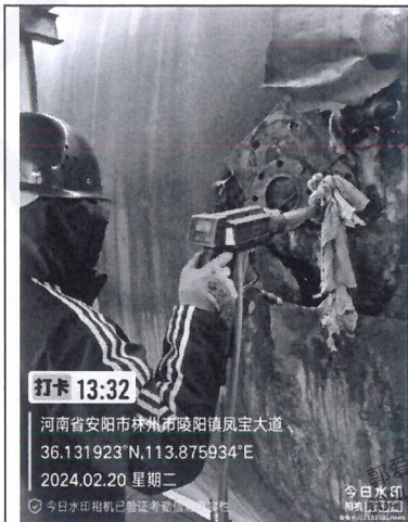
烧结机头排气筒出口
